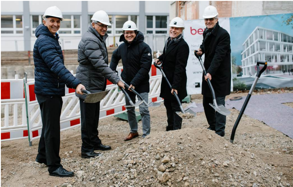
Spatenstich, v.l.n.r.: Beurer Geschäftsführer Marco Bühler, Gunter Czisch, Oberbürgermeister der Stadt Ulm, Axel Nething, Geschäftsführer Architekturbüro Nething, Ralph Merkle, Leitender Architekt und Otto Sälzle, Hauptgeschäftsführer der IHK Ulm.
